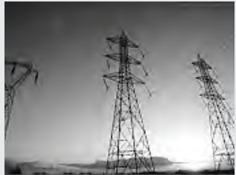
Pylônes double drapeau ou à 2 circuits.
