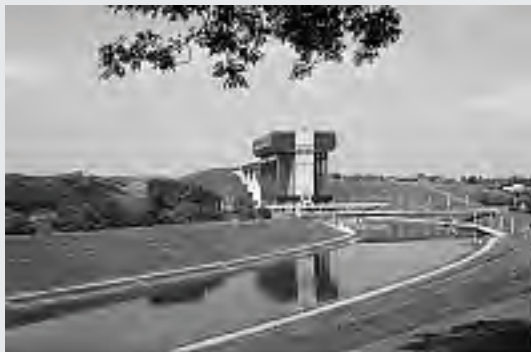
L'ascenseur à bateaux de Strépy-Thieu sur le canal du Centre, au gabarit européen, peut monter les péniches de 1 350 tonnes à plus de 73 mètres du sol en 6 minutes.
